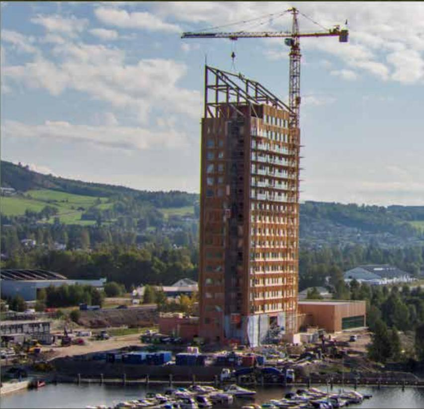
En 2019, se completó en Brumunddal, Noruega, el Mjøstårnet, un rascacielos de madera que, con 18 pisos y 80 metros de altura, se convirtió en el edificio de madera más alto del mundo en su momento.
