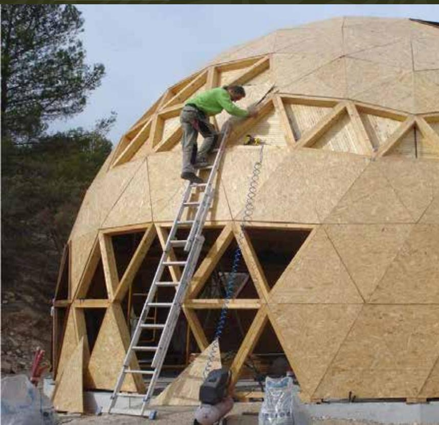
El Gimnasio Geodésico para un Colegio en Burgos, diseñado por Ecoprojecta, es una estructura innovadora que combina funcionalidad, estética y sostenibilidad. La elección de una cúpula geodésica como modelo de construcción permite aprovechar la geometría eficiente de esta estructura para maximizar el espacio interior, optimizando tanto la distribución como la resistencia estructural.
