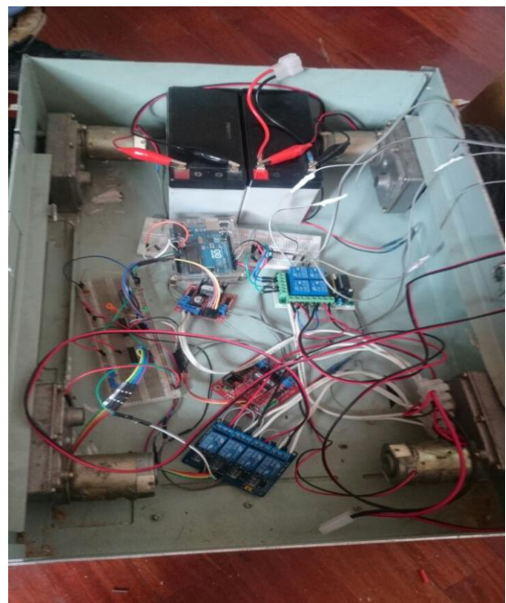
Figura 13. Chasis con su circuito eléctrico y electrónico
