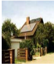
Aplicación de Paneles
