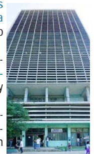
Rompesoles de edificio de la Universidad de La Habana ejemplo de diseño bioclimático.
