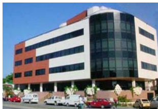
Ventanales de cristales causan efecto invernadero en el interior sobrecargan a los equipos de A.A..
