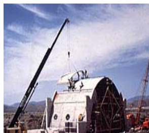
Construcción de Bóvedas para reuniones
