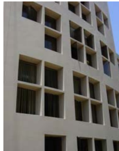
Fachada con protección solar.
