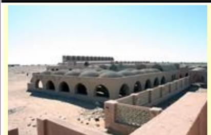
New Baris Village, ubicado en Egipto-Africa. La masa térmica de los materiales utilizados y la manipulación de movimiento natural del aire como las únicas respuestas posibles para disipar tanto calor, el cual logra reducir hasta los 15C°
