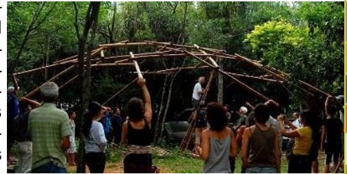
Arquitecto Guillermo Gayo construyendo una estructura de Bambú
