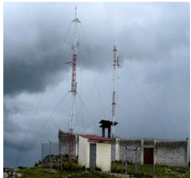
FIGURA 3-5 Infraestructura en Laykatuyoc
