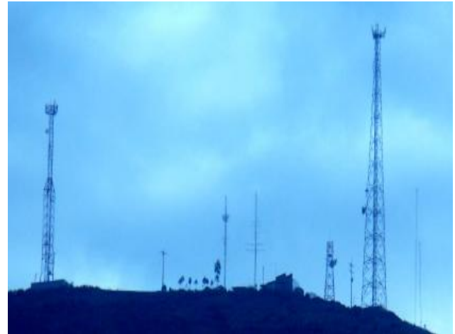
FIGURA 3-4 Infraestructura en Qosqohuarina
