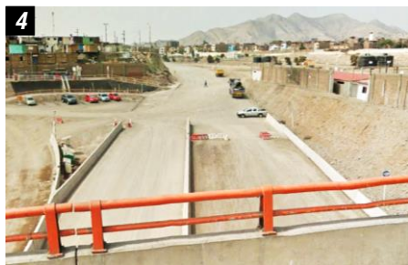
Vía Parque Rímac bajo Puente Huánuco
