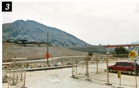
Viaducto hacia Barrios Altos
