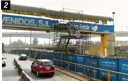
Paradero y accesos inadecuados
