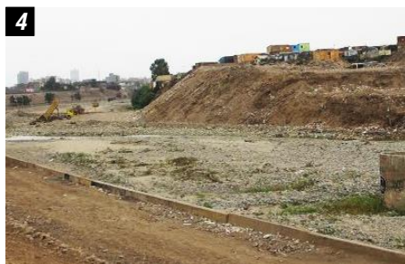
Área baldía en la margen izquierda
