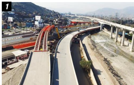
Viaducto – Vía Parque Rímac
